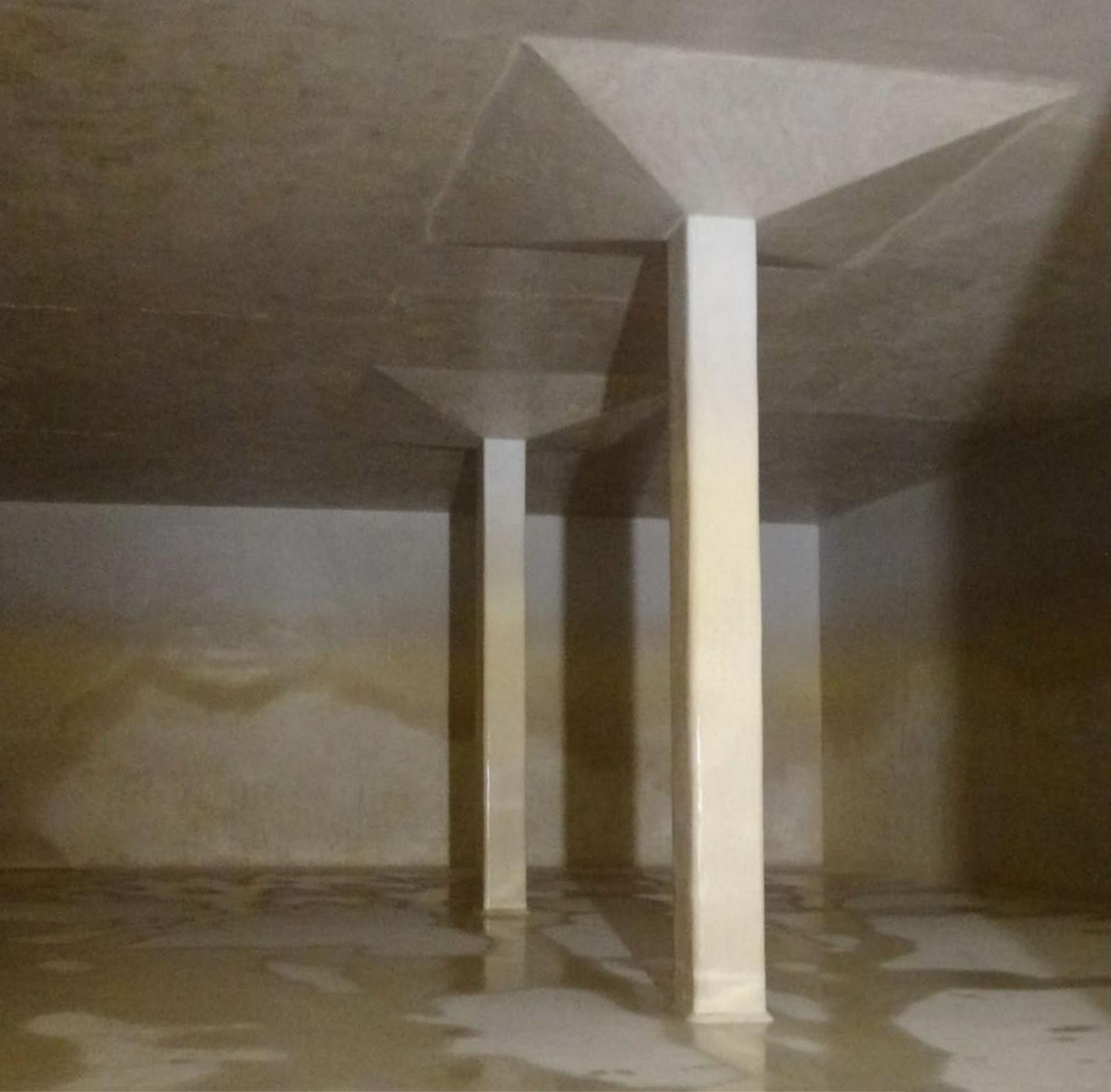
Schadensbild: Hydrolytische Korrosion
